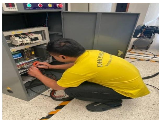
รูปที่ 4 วัดแรงดันไฟฟ้า (V) และความถี่ (Hz)
