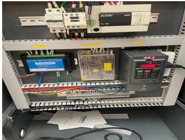
รูปที่ 2 ชุดควบคุมอินเวอร์เตอร์
