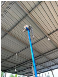
9. ติดตั้งกังหันลม - ทำการใส่สายกันลมแบบถอดประกอบ
