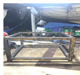
1 ทำฐานเครื่องจักร -นำเหล็กมาเชื่อมทำโครงสร้างฐาน
