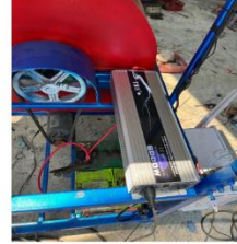
11. ติดตั้งอินเวอร์เตอร์ - ทำการติดตั้งอินเวอร์เตอร์ด้านบนจุดที่ระบายความร้อนได้ง่าย
