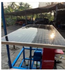
8. ติดตั้งแผงโซล่าเซลล์ - ทำการติดตั้งแผงโซล่าเซลล์เข้ากับโครงในจุดรับแสงแดด
