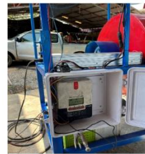
12. ติดตั้งตู้ควบคุม - ทำการติดตั้งระบบควบคุมกระแสไฟของเครื่อง
