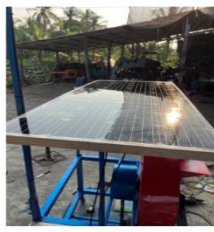
8. ติดตั้งแผงโซล่าเซลล์ - ทำการติดตั้งแผงโซล่าเซลล์เข้ากับโครงในจุดรับแสงแดด
