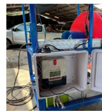
12. ติดตั้งตู้ควบคุม - ทำการติดตั้งระบบควบคุมกระแสไฟของเครื่อง
