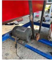
6. ติดตั้งมอเตอร์ - ทำการติดตั้งมอเตอร์ให้ตรงตำแหน่งของร่องสายพาน - และทำการติดตั้งสายพานที่มอเตอร์และวิน
